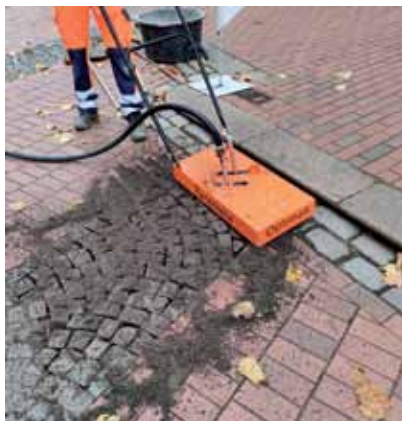
Der Optimas FugenBooster reinigt Fugen tief, gleichmäßig und ohne Sand oder Steine umherzuwirbeln.
