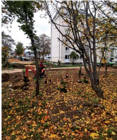
Bau eines Spielplatzes im Ahrtal
