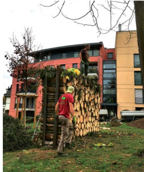
Fotos: VGL NRW Bau eines Insektenhotels im Ahrtal
